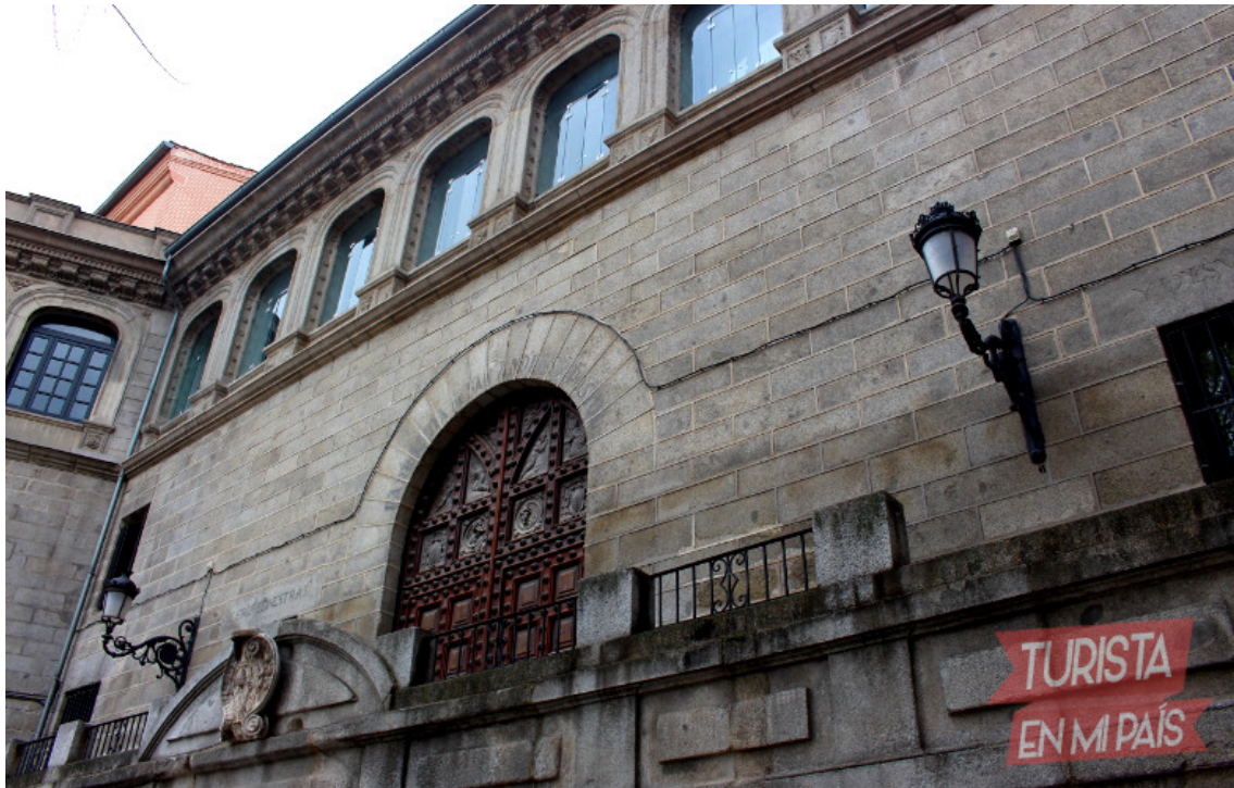
Fachada principal de la Capilla del Obispo, en la Plaza de la Paja de Madrid
